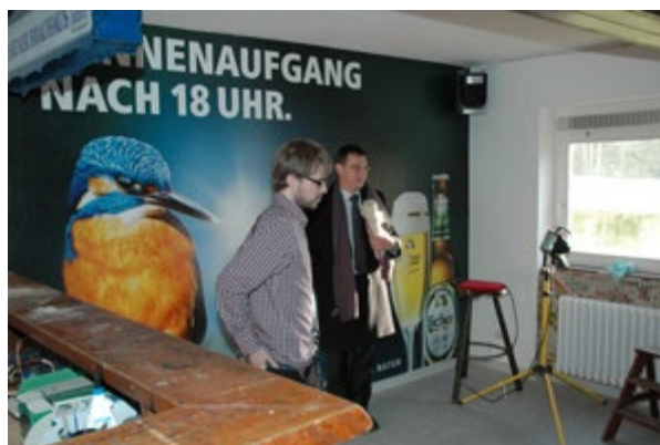
Auch die Ortsbesichtigung der neuen Kollegbar darf nicht fehlen! Nicolai Stauch informiert Dr. Volker Jung über den Baufortschritt der Schüler-Eigeninitiative.
